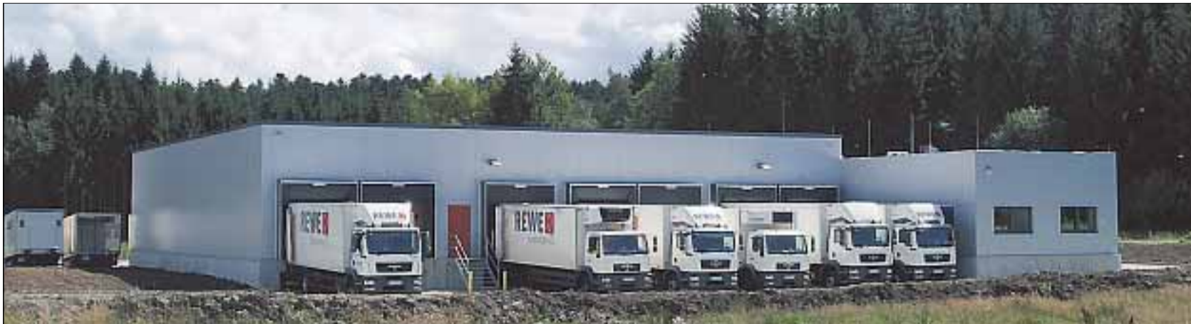
Die Lagerhalle der bisher einzigen Firma im Gewerbegebiet Neuen liege „versteckt“ – „der Wald muss weg“, fordert deshalb die CDU.
